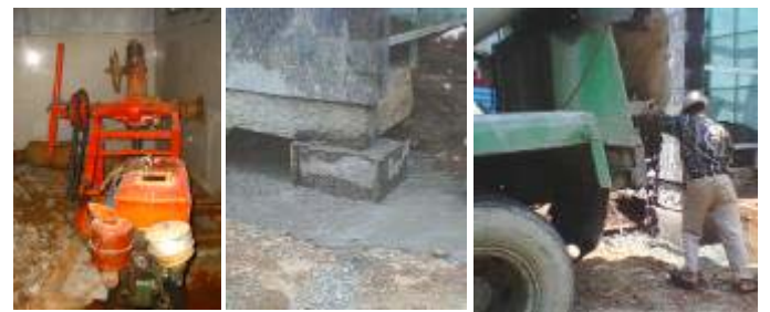
Minipile Underpinning at Gedung Serba Guna Universitas Terbuka, Lemtek Universitas Indonesia
